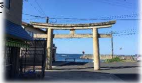
修繕前の鳥居のようす
